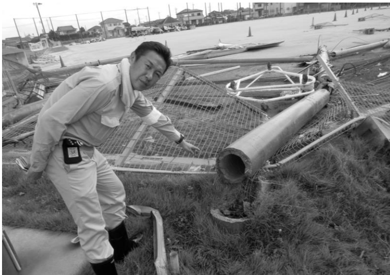
グラウンドのネットの支柱がなぎ倒された現場。竜巻の威力がまざまざと伝わってきます
